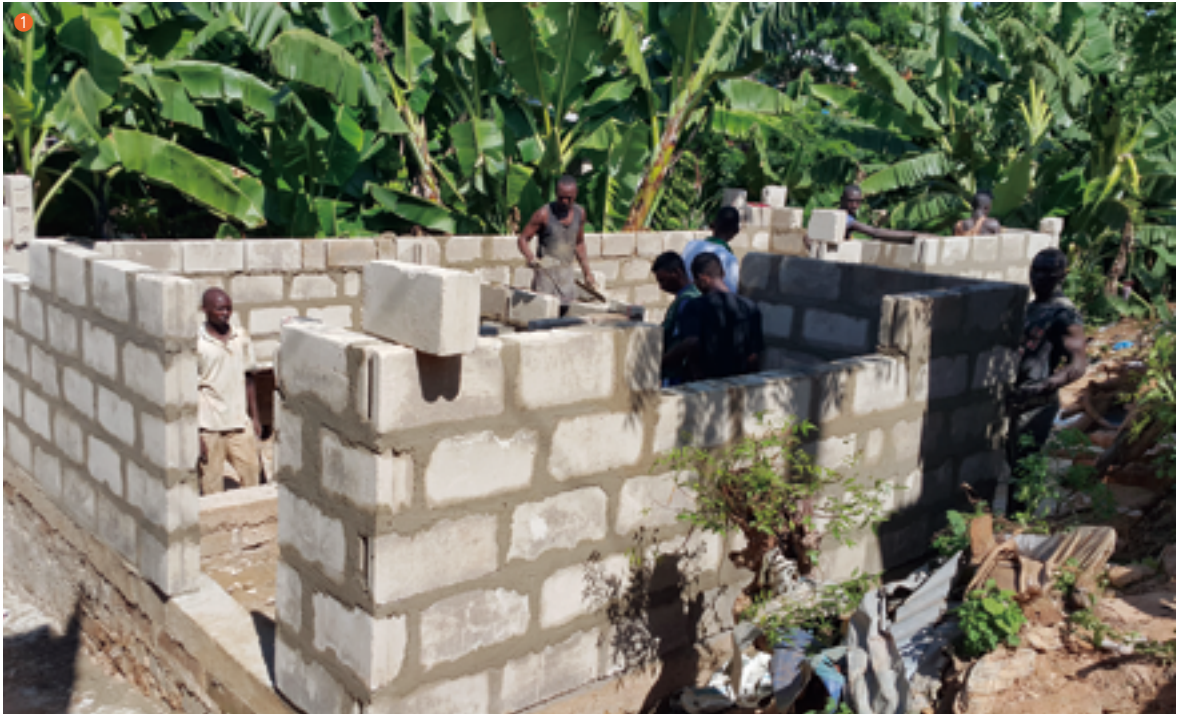
① 소피아네 새집 공사
